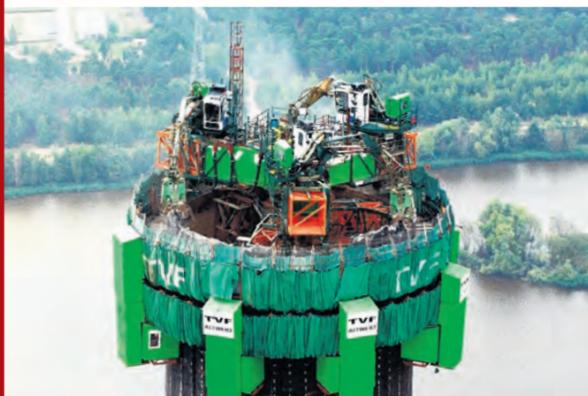
Der Abbruch der drei Schornsteine im Kraftwerk Jänschwalde war mittels Statikberechnung, dem Einsatz einer Kaminabbruchmaschine und gesteuerter Sprengung ein erfolgreiches, einmaliges Projekt
